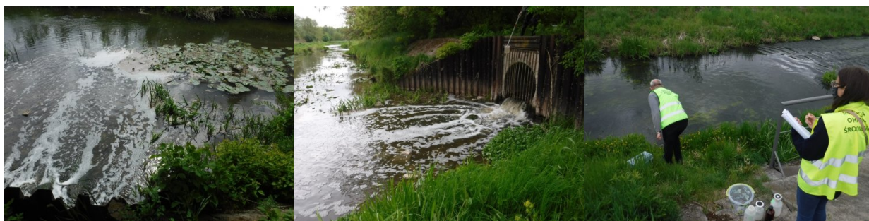
Wylot z oczyszczalni do rzeki Łydynia
