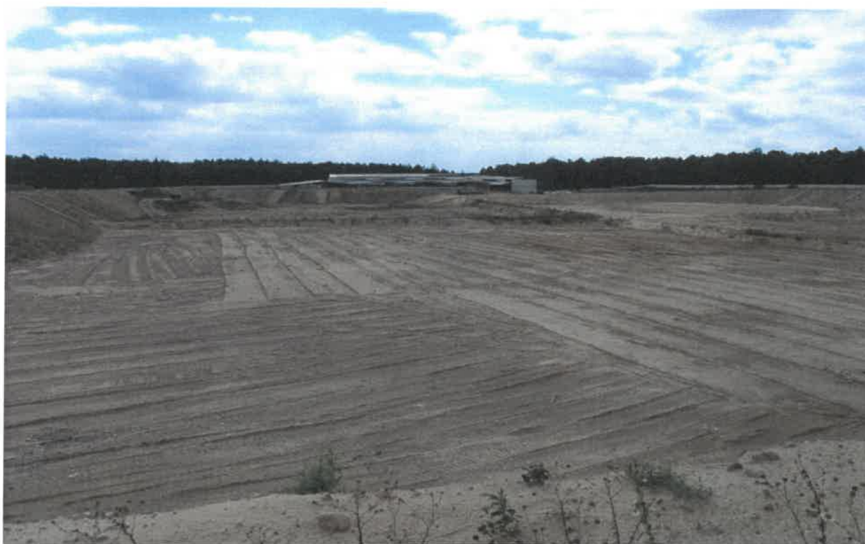
Fot. 7.5. Składowisko odpadów w m. Kosiny Bartosowe, gmina Wiśniewo, powiat mławski – pierwsza kwatera
