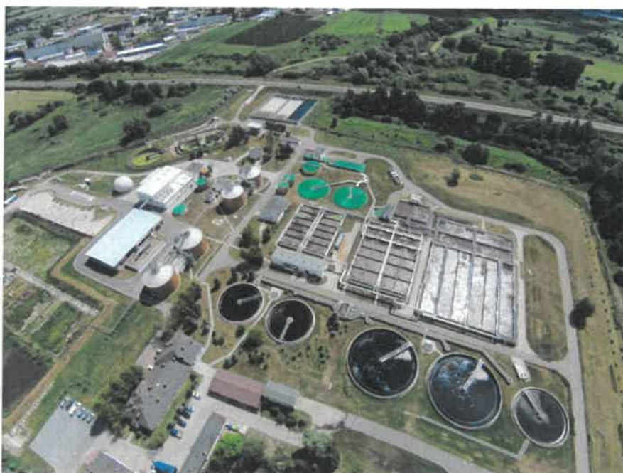
Fot. 3.1. Miejska Oczyszczalnia w Siedlcach po rozbudowie i modernizacji (zdjęcie przekazane przez PWiK Sp. z o.o. w Siedlcach)
