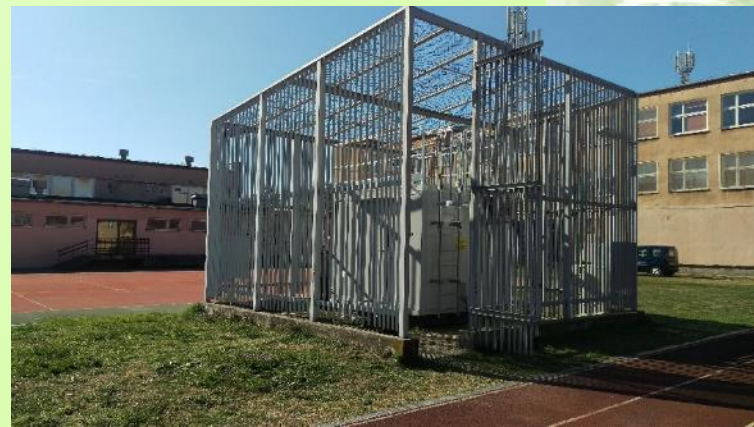
kontrole poprawności lokalizacji stacji i monitorowanie zmian w otoczeniu stacji
